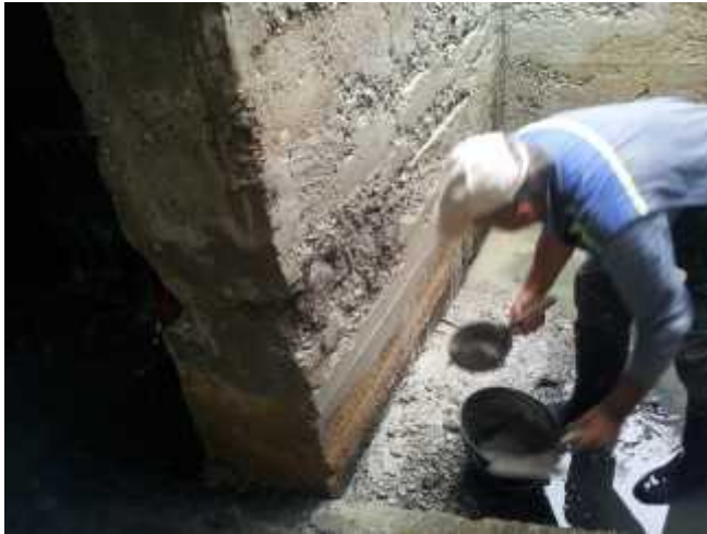
Nanošenje reparaturnog maltera
