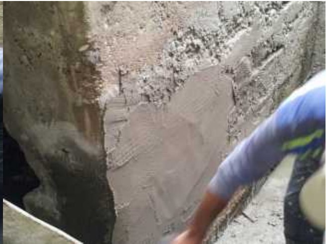
Nanošenje reparaturnog maltera
