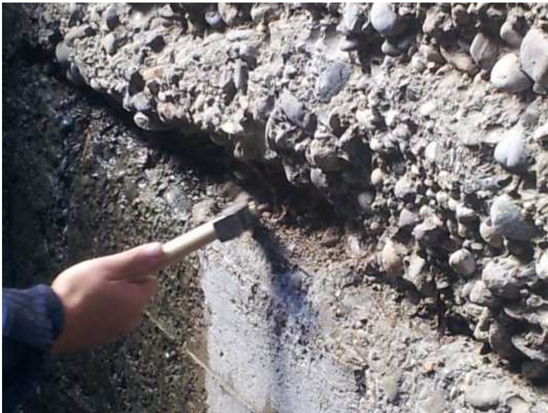
iš enje ošte enog betona
