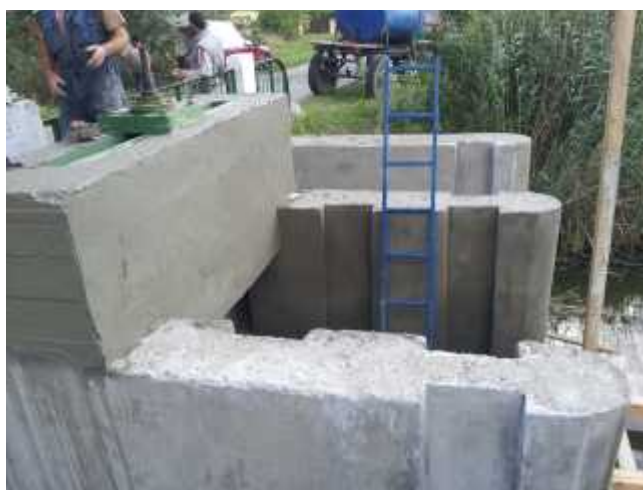
Finalna zaštita reparaturnog maltera sa XYPEX Modified
