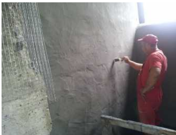
Finalna zaštita reparaturnog maltera sa XYPEX Modified
