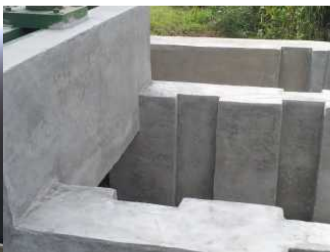
Finalna zaštita reparaturnog maltera sa XYPEX Modified
